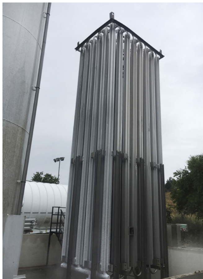
Obr. 1.11 Ukázka odpařovací jednotky s vertikálními trubkami opatřenými podélnými žebry, zdroj [17]
