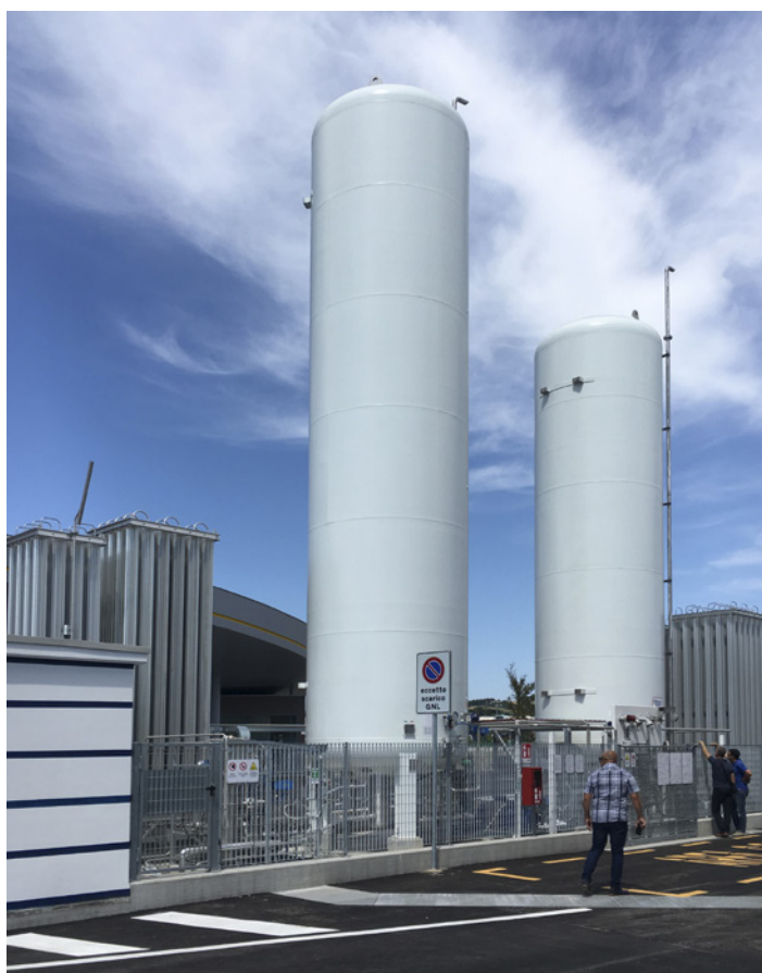
Obr. 1.6 Ukázka velkoobjemových vertikálních zásobníků, zdroj [17]
