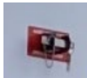
Tlačítko nouzového vypnutí (ESD)
